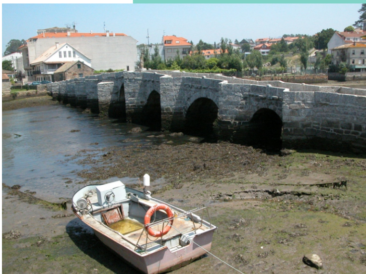
Ponte da Ramallosa, ou ponte da Xunqueira, do século XIII, compartida entre Nigrán e Baiona. É unha das pontes de Galiza na que se realizaba o ritual do Bautismo Prenatal.
